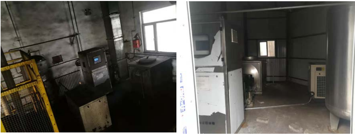
图 8 洒水抑尘设施
