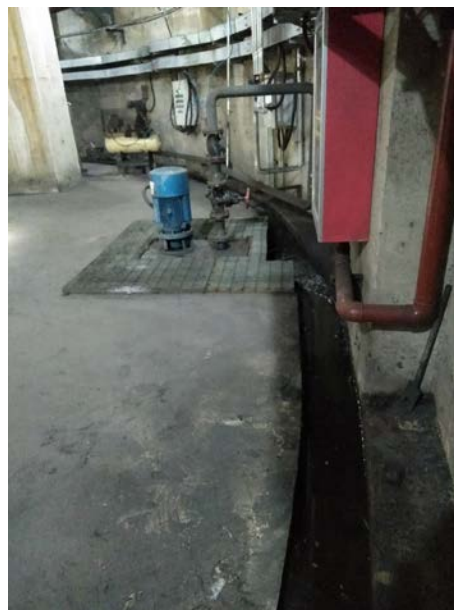
图 14 筒仓底部集水坑
